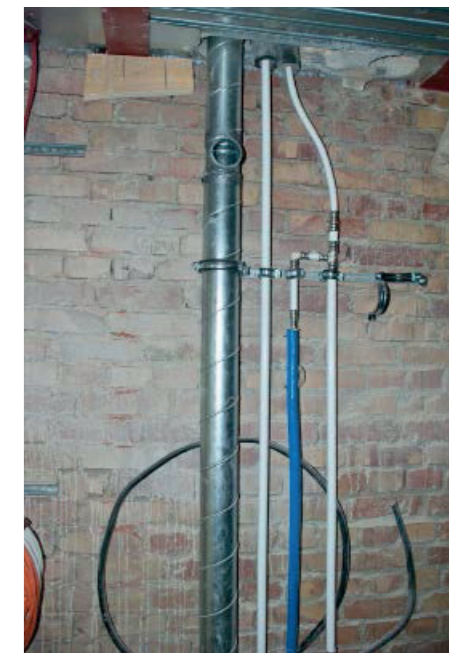
Zirkulationsleitung mit vorgedämmtem Rohr von Multitubo systems von der Rolle verlegt.
